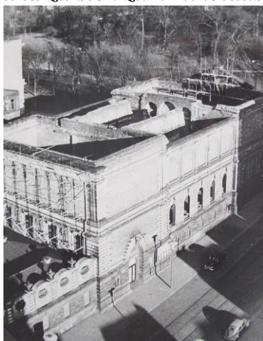
Die zerstörte Kunsthalle; © Foto Paul Korn, 31.12.1954
